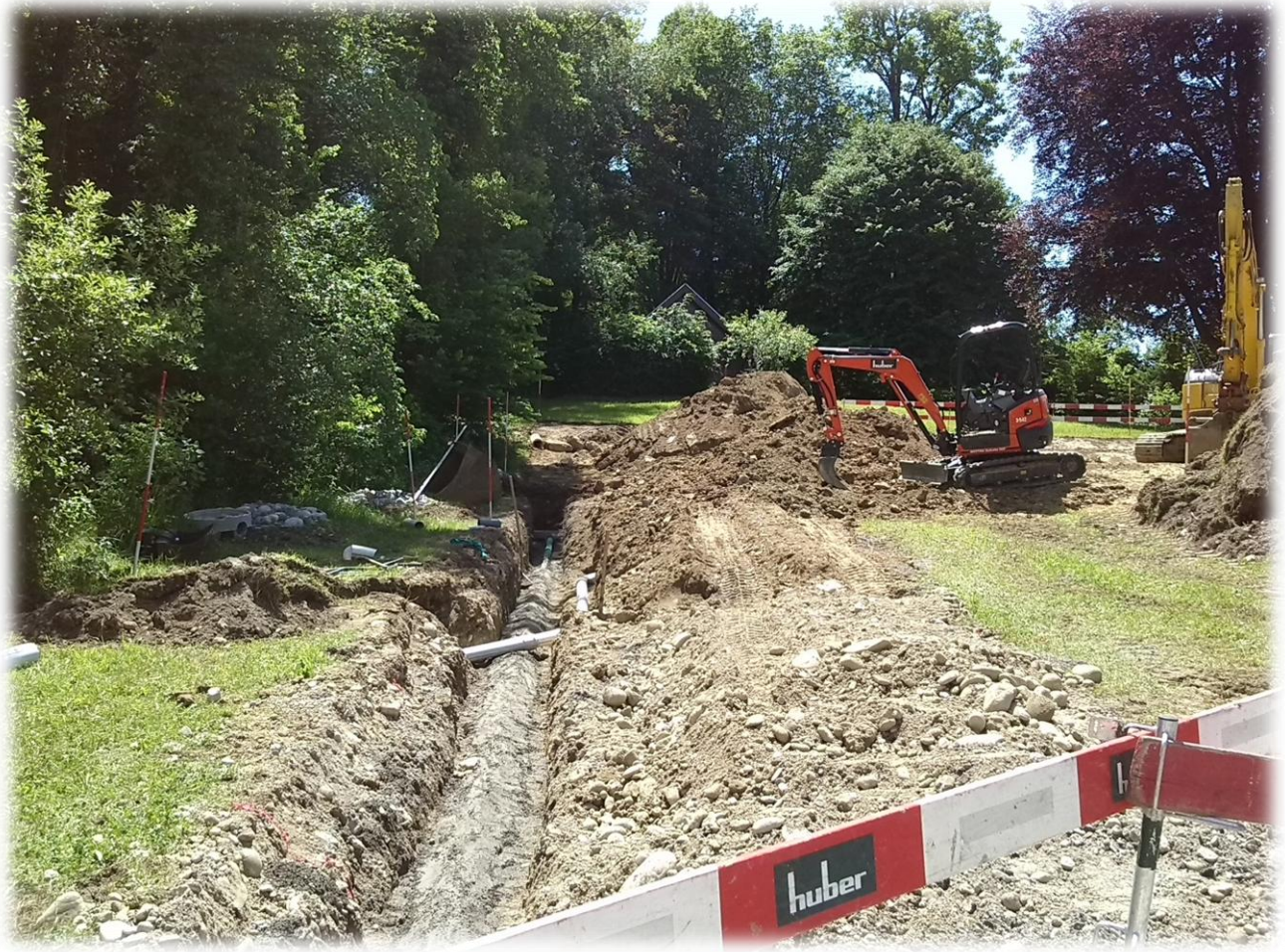
Erstellen der Frischwasser- und Abwasserleitungen
