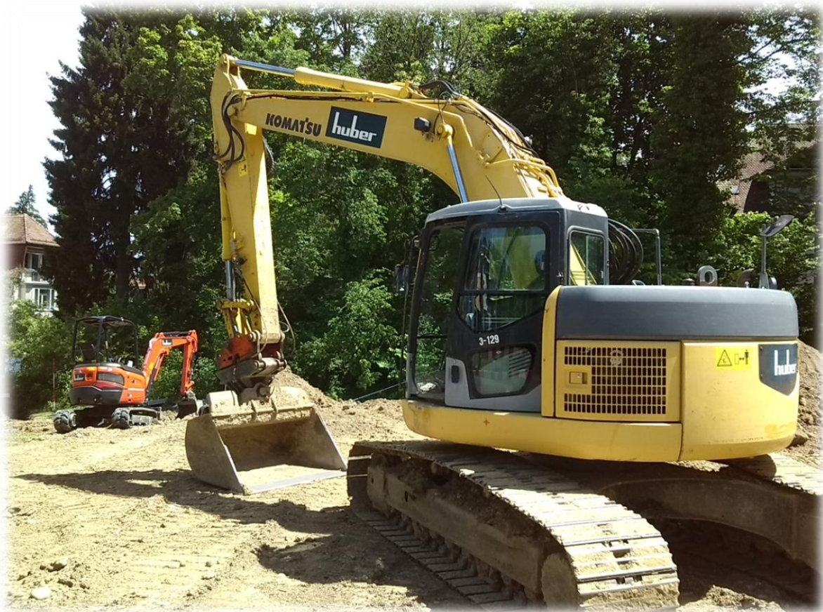
Terrainvorbereitung für Kindergarten-Provisorium
